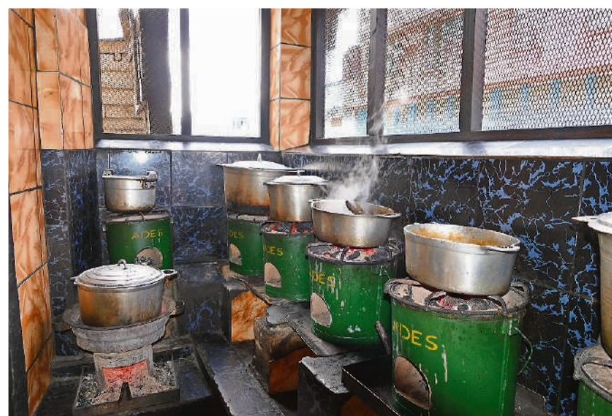
Energiesparkocher und Lüftung verbessern die Situation in den Grossküchen der Schulen deutlich. (Bilder zvg.)
